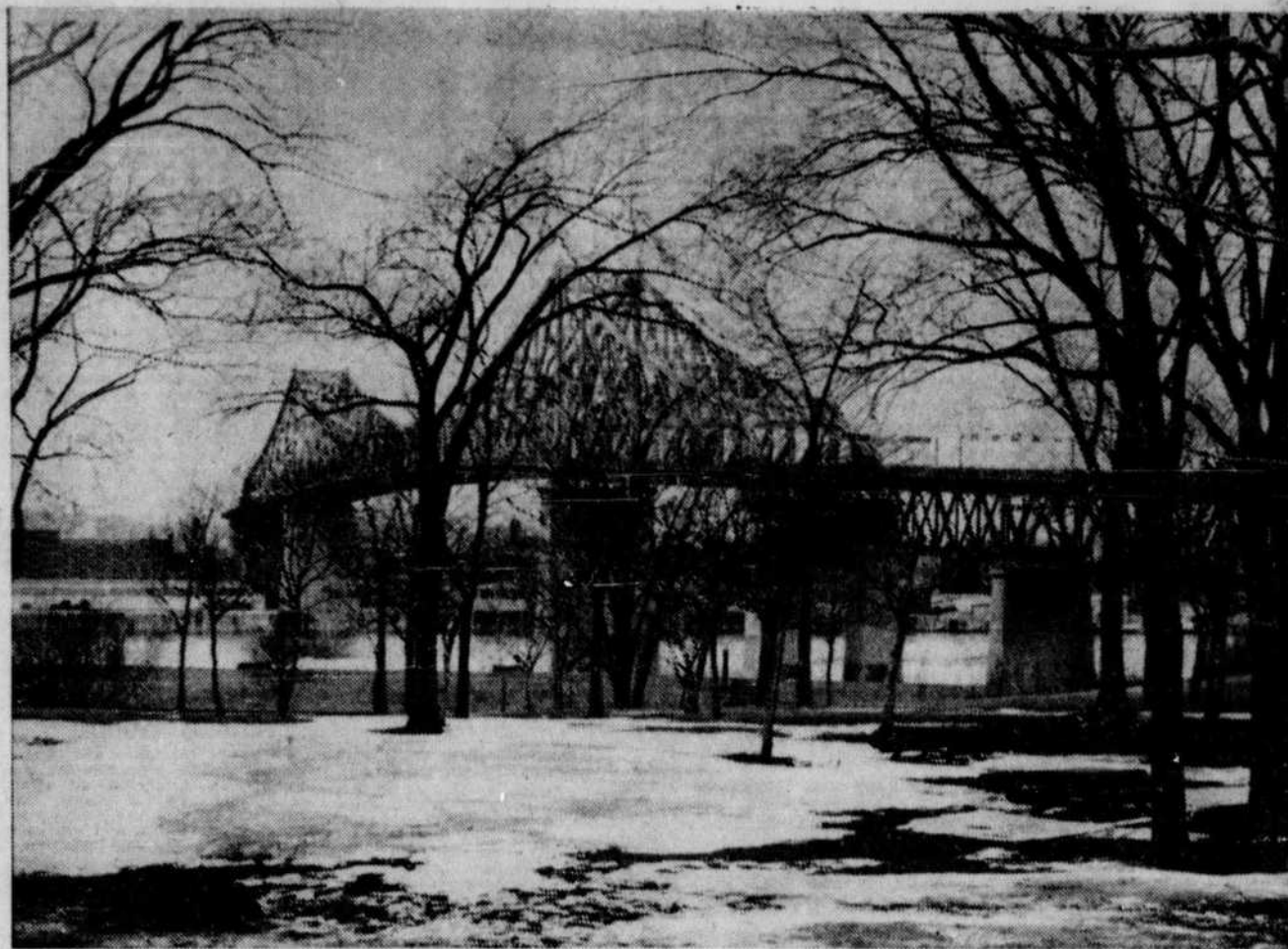
Les squelettes de bois noir des arbres de Sainte-Hélène se détachent sur celui de métal du pont Jacques-Cartier. Mais ce dernier, même quand sera venu l'été, ne sera pas plus feuillu qu'aujourd'hui. Le parc insulaire, quant à lui, accueillera de nouveau les enfants sous ses frondaisons, dès le beau temps revenu. D'aucuns se sont récemment inquiétés qui craignaient qu'en dépit des promesses formelles de la ville, le parc doive céder devant la boulimie de l'Expo. Notre photographe, Denis Saint-Jean, aussi sensible que sa pellicule aux charmes d'une nature qui renaît, est allé voir si les bull-dozers "osaient" s'attaquer à "son" parc. Il nous rapporte que s'ils ont, effectivement, osé, par-ci par-là, ils ont aussi respecté le reposant visage de ce parc, justement cher aux Montréalais.
