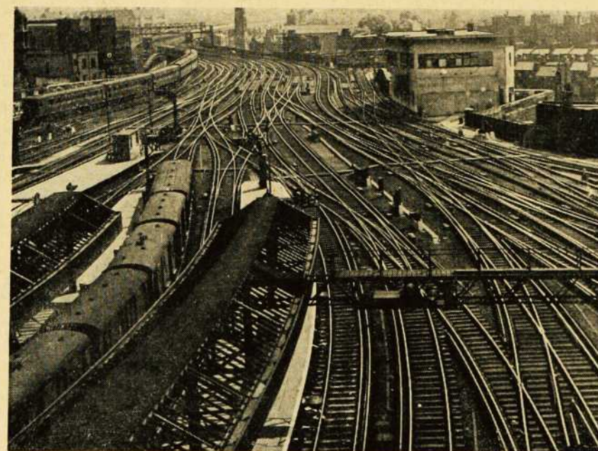
L'enchevêtrement compliqué de voies ferrées que montre cette photo est une des voies d'accès à l'une des plus grandes gares de Londres. Toutes les pointes de croisement qu'on aperçoit sont actionnées de la cabine d'aiguillage à droite. On peut se rendre compte de l'énorme responsabilité des aiguilleurs en précisant que dans les quatre semaines qui suivirent le jour D, les chemins de fer britanniques battirent tous leurs records en mettant en service 17,500 trains spéciaux pour le transport de troupes et de ravitaillement en vue de l'invasion. On a compté, en outre, 113 trains spéciaux pour le transport de la correspondance et colis destinés aux armées de même que des trains-hôpitaux, sans parler de ceux qui firent le transport des prisonniers allemands.
