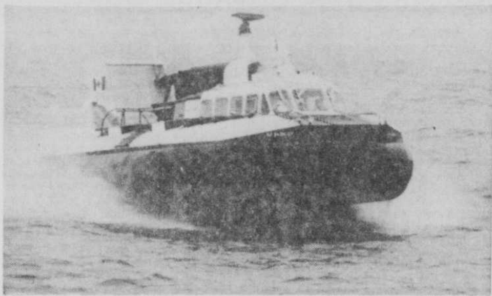
L'aéronef britannique Hovercraft, qui possède la propriété de se propulser sur un coussin d'air, file à plus de 50 m.p.h. entre les îles de l'Exposition universelle. Il peut ainsi parcourir des voies d'eau peu profondes et même surmonter des obstacles solides de plus de deux pieds de hauteur. Le service Hovercraft de l'Expo relie les points stratégiques de l'aménagement. Il n'est pas gratuit.
