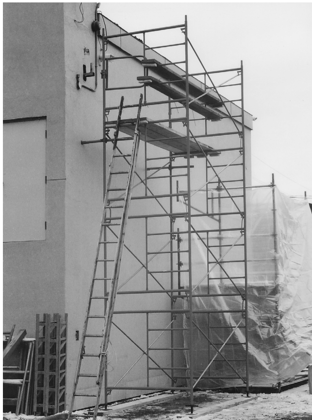
Échafaudage sur cadres métalliques traditionnels
