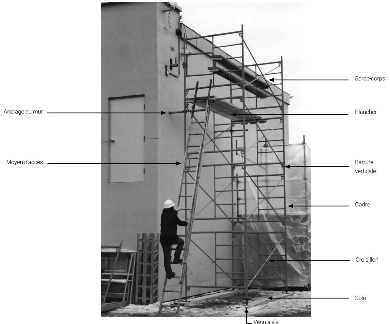
Composants des échafaudages sur cadres métalliques
