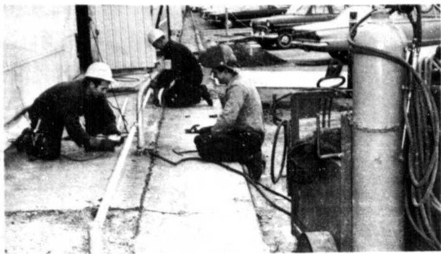
LES NOUVELLES SORTIES - Ces tuyaux d'aluminium contiendront autant de circuits que nécessaire, depuis la source d'alimentation jusqu'aux sorties du courant. Sont au travail, MM. Doilard Belley et Julien Pilote, électriciens et M. François-Nil Ouellet, soudeur
