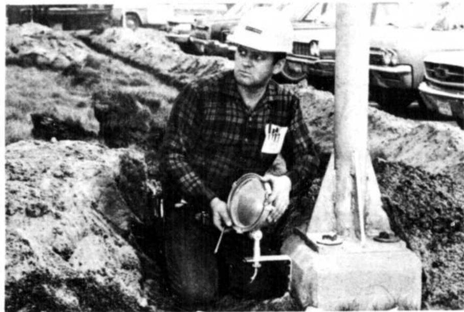
LE SYSTEME D'ILLUMINATION - Des projecteurs comme celui-ci que vient d'installer M. Lévis Tremblay assureront l'illumination de la façade de l'édifice des bureaux, aujourd'hui recouverte de panneaux de revêtement Alcan.
