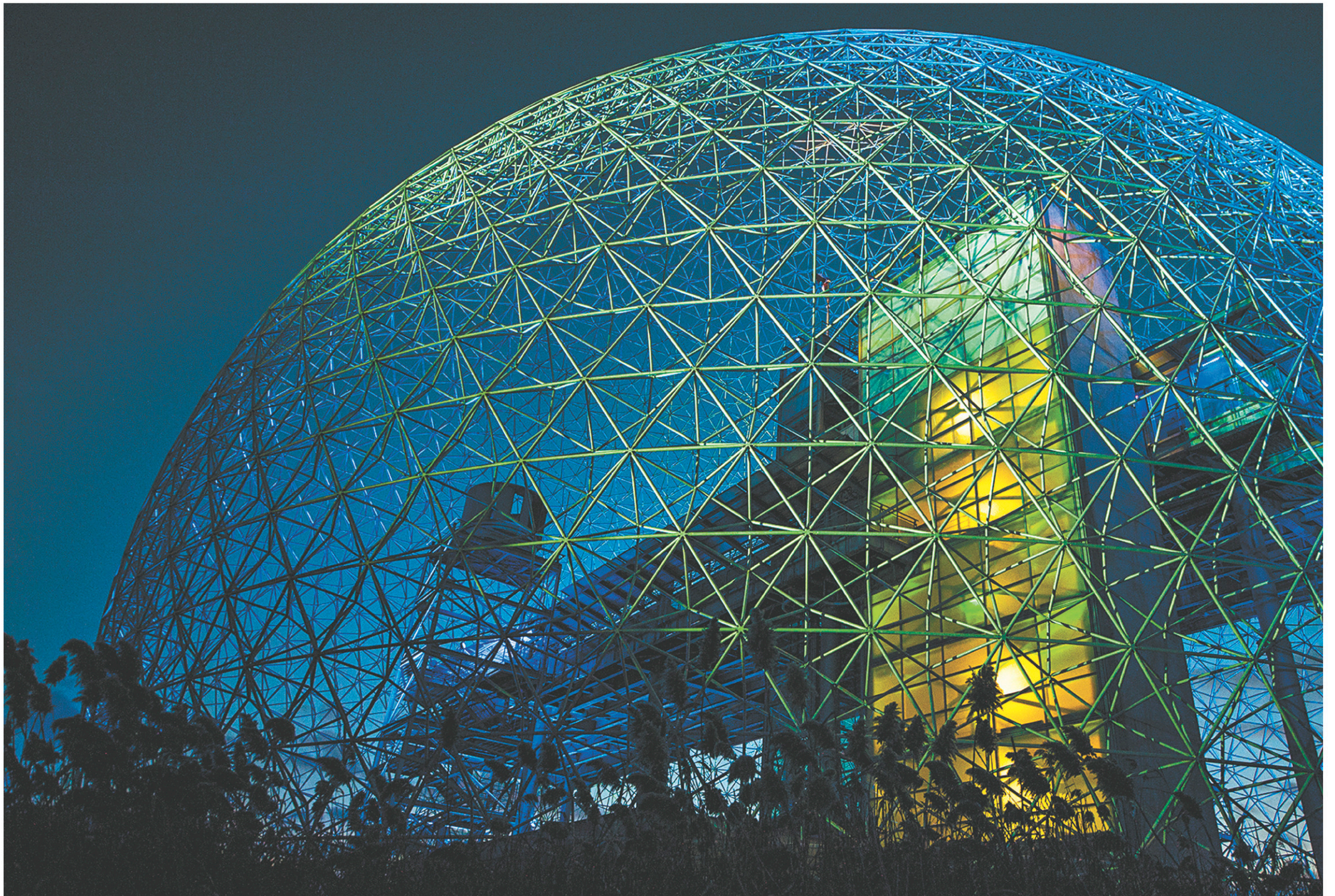
La Biosphère, à Montréal, utilise un système à boucle ouverte depuis 1995. L'eau pompée, dont la température varie de 9 à 13 degrés Celsius, est puisée à environ 90 mètres sous terre. ENVIRONNEMENT ET CHANGEMENT CLIMATIQUE CANADA
