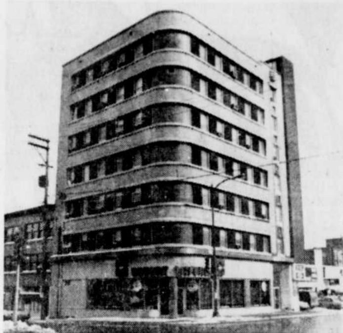
Bureau principal (Face à la gare centrale), 210, boul. Charest est, 529-1714
