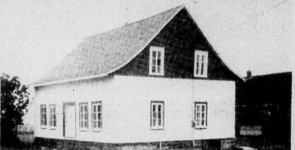
Rivière-Hâtée , maison centenaire, construite pièces sur pièces, en voie de rénovation. Nicole Drapeau, 723-1373. 722-7695.
