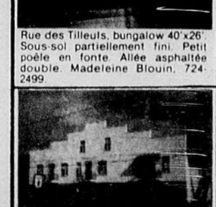
Mont-Joli, rue de la Gare. Immeuble à revenus 3 étages. Finition extérieure imitation de pierre et clapboard. Adélaïde Roussel, 775-4635.
