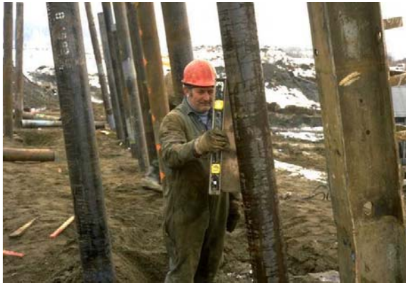
13. Contrôle de la pente des pieux battus
