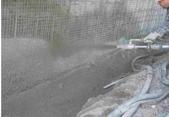
7. Technique de projection adéquate
