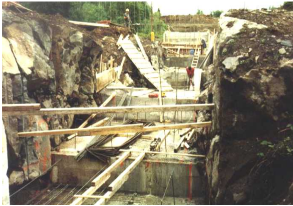
1. Excavation de première classe en paliers
