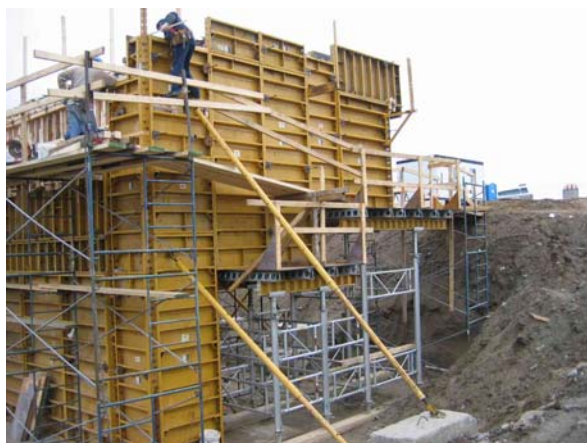
2. Coffrages verticaux préfabriqués
