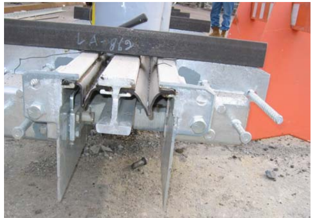
6. Joint de tablier à plus d'une garniture
