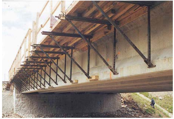
8. Supports de coffrages de dalle en porte-à-faux
