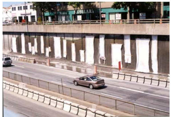
12. Cure humide du béton projeté
