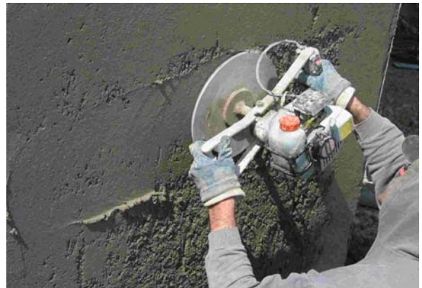
10. Finition à l'aide de la truelle rotative
