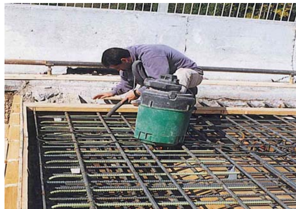
18. Nettoyage final des coffrages
