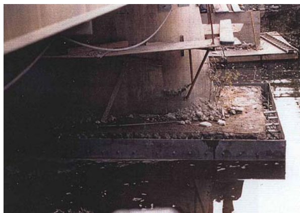
42. Coffrage métallique pour bétonnage sous l'eau
