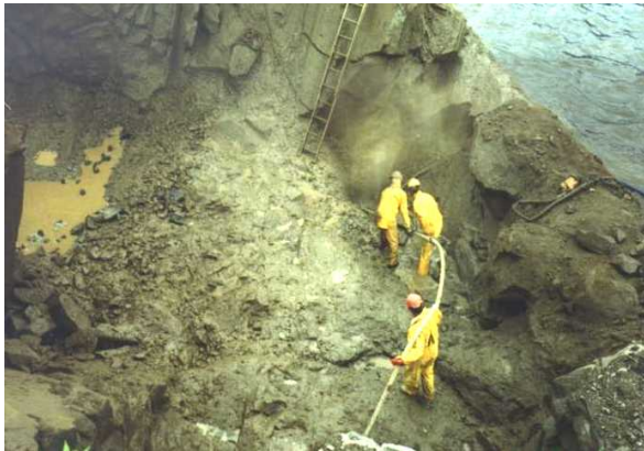
3. Nettoyage de la surface du roc
