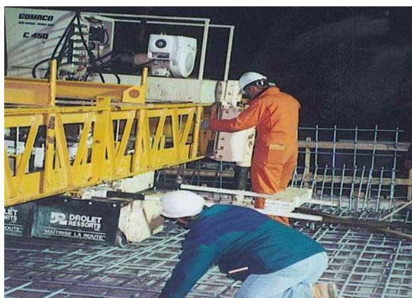
30. Ajustement du finisseur à béton automateur
