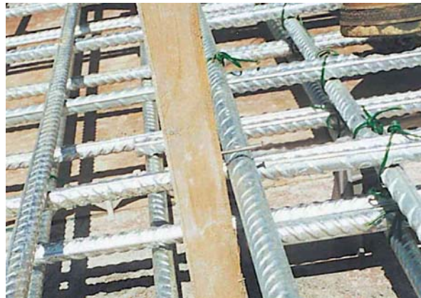
16. Bâton et clou pour vérifier l'élévation des armatures (par rapport au coffrage)
