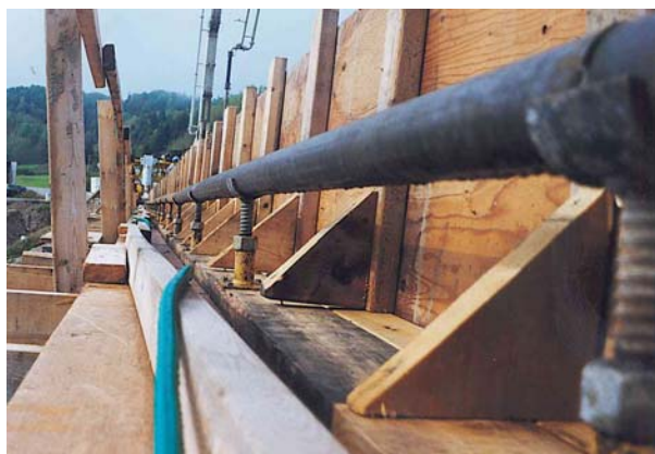
25. Rail de roulement pour équipement de finition pour le béton de la dalle
