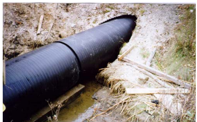
6. Insertion d'un tuyau en polyéthylène à haute densité à l'intérieur d'un tuyau en tôle ondulée
