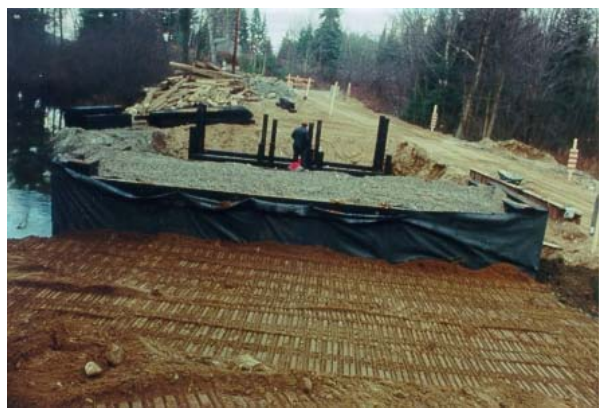
5. Remplissage des excavations à l'arrière d'une culée de type caisson
