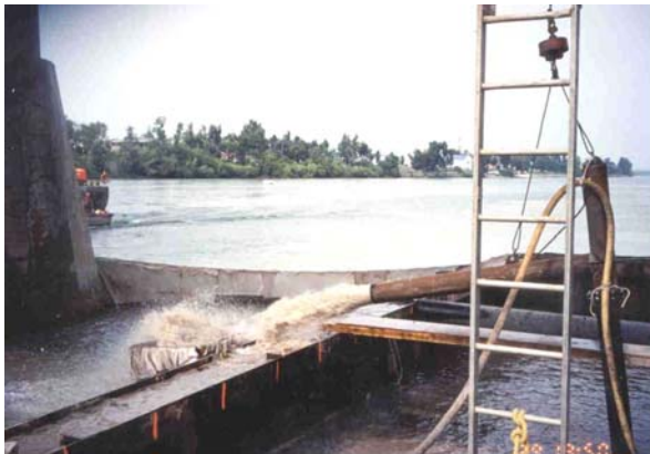
15. Trappe à sédiments (entre batardeau et pile existante)
