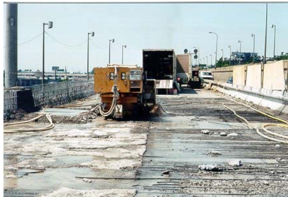
6. Hydrodémolition sur dalle
