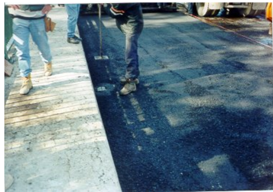
6. Compactage près d'un drain
