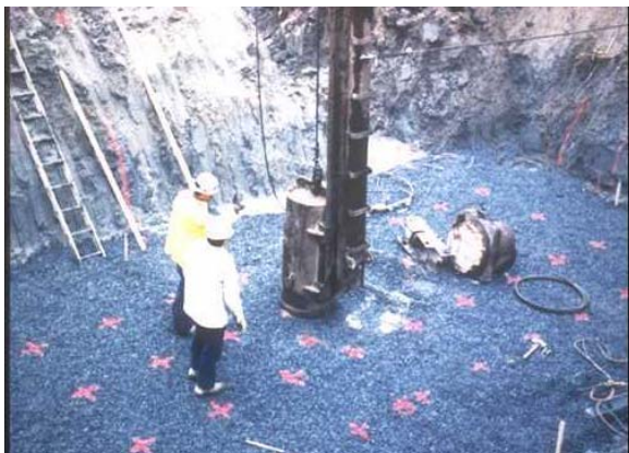
11. Repères pour localisation des pieux
