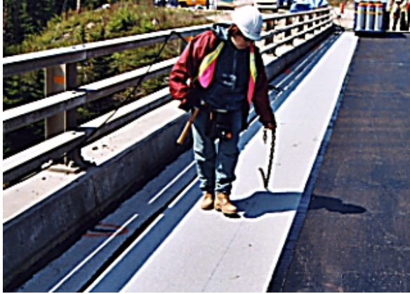
7. Vérification de l'adhérence de la membrane (chaîne)
