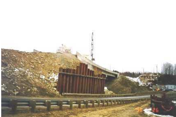
17. Soutènement temporaire en palplanches métalliques
