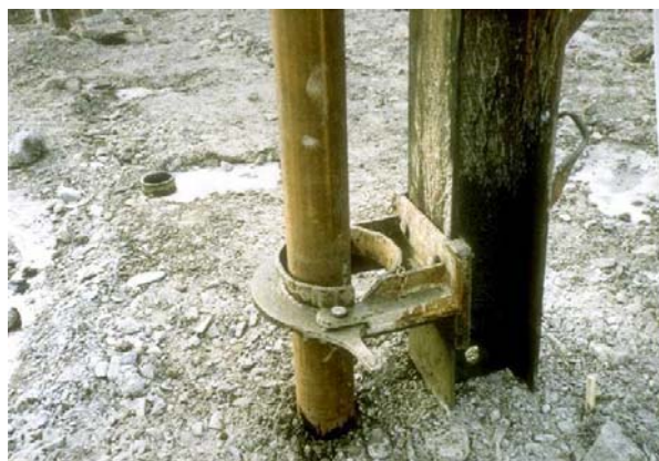
6. Guide d'alignement sur la jumelle
