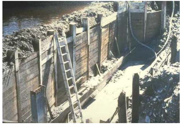
8. Mur berlinois à l'intérieur d'un batardeau en terre
