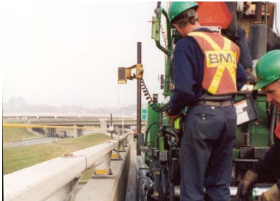
3. Mise en place de la couche de correction (avec guide)
