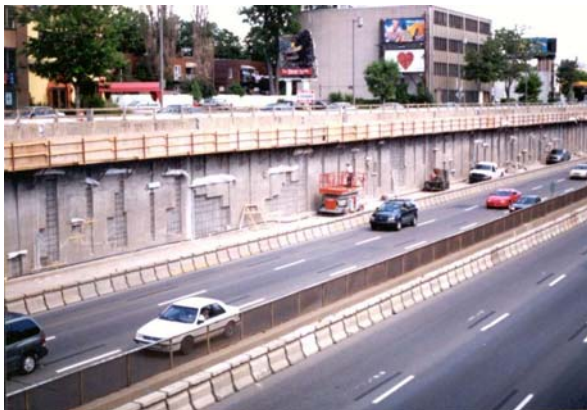
11. Installation du système de cure avant la projection
