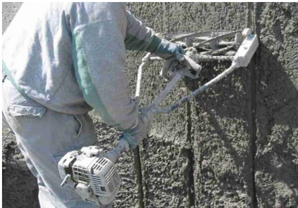
9. Arasement de la surface de béton
