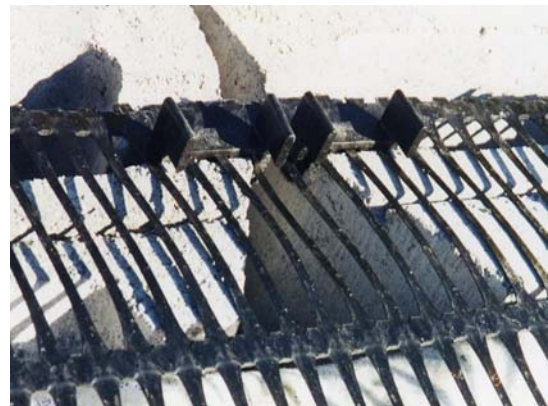
4. Connexion mécanique des géogrilles aux blocs remblai
