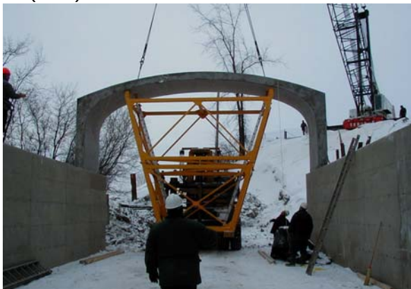
3. Mise en place de la partie supérieure d'un ponceau voûté en béton armé
