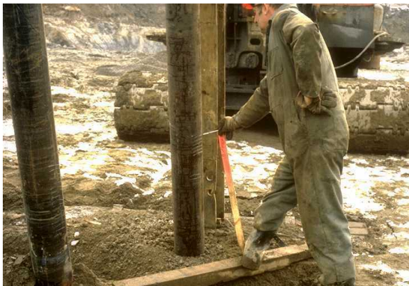
15. Mesure de l'enfoncement d'un pieu battu
