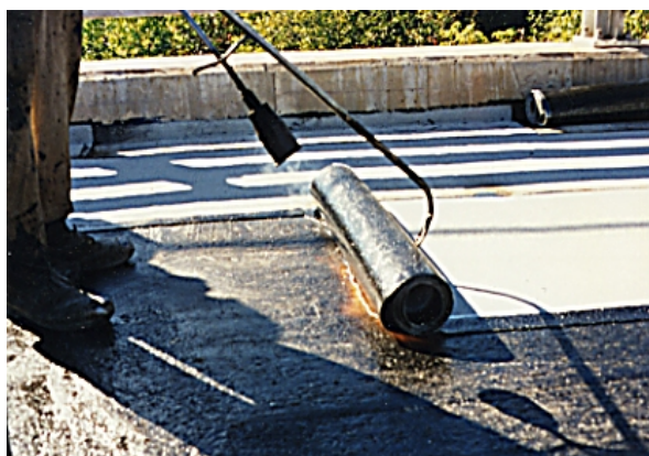
5. Chalumeau à buse simple
