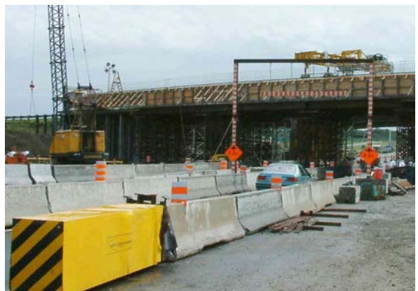
12. Protection d'étalement avec gabarit et glissières
