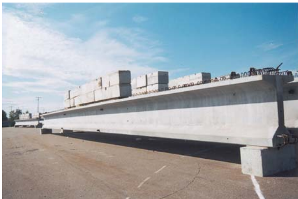
9. Chargement de poutres préfabriquées
