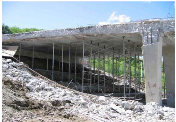
10. Étalement (travaux d'entretien)
