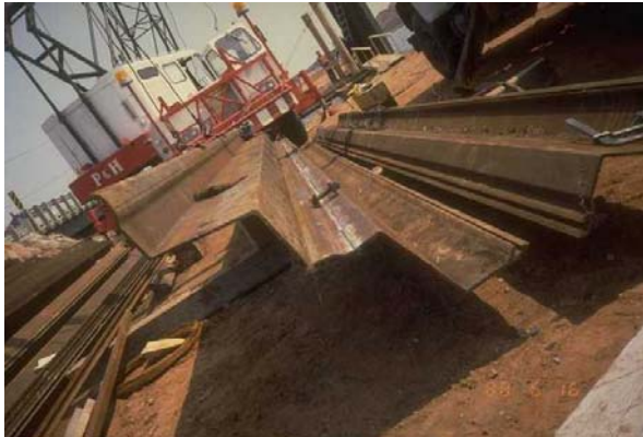
9. Section type de palplanches métalliques
