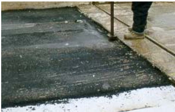
5. Compactage près d'un joint de tablier
