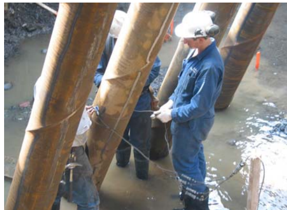
16. Instrumentation d'un pieu pour l'essai dynamique
