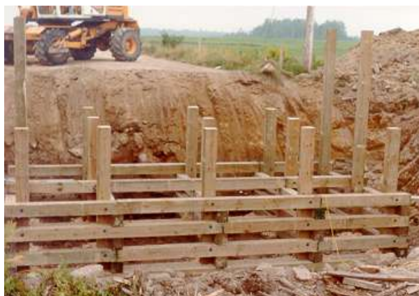
2. Début de construction d'un caisson
