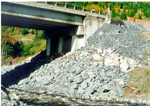
23. Revêtement en pierres sur un remblai d'approche
