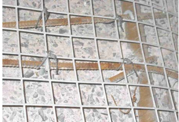
2. Fixation du treillis métallique
