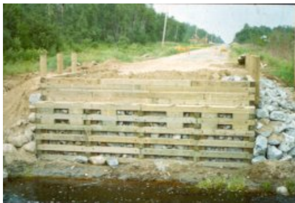
3. Culée de type caisson
