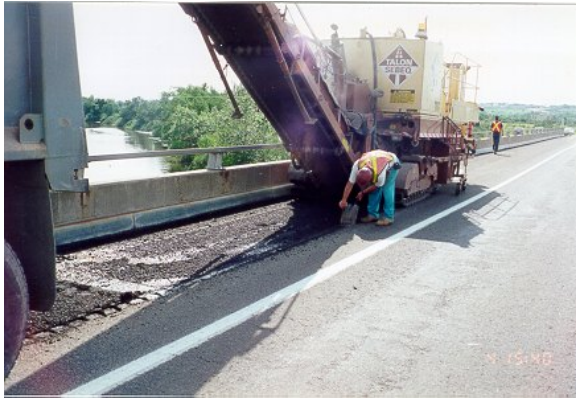
1. Planeur de 1,8 m de largeur – mesure de l'épaisseur planée
