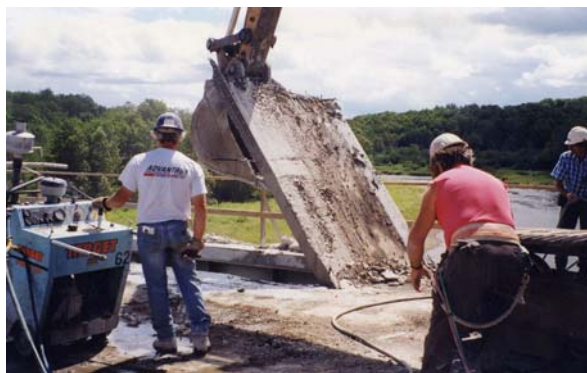
2. Enlèvement des parties de dalle sciées
