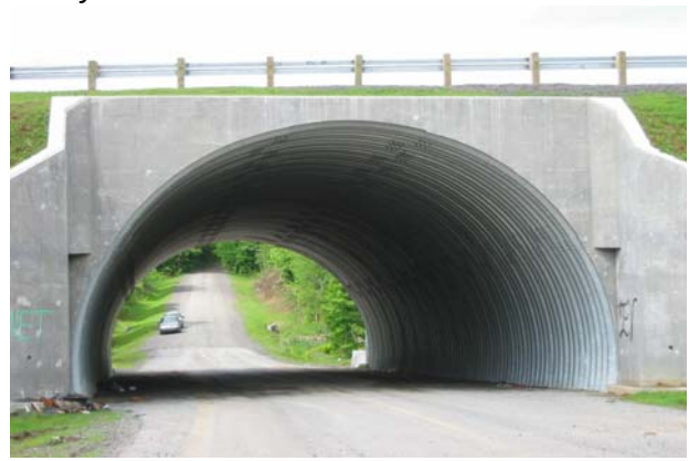
4. Tuyau voûté en tôle ondulée galvanisée sur semelle en béton
