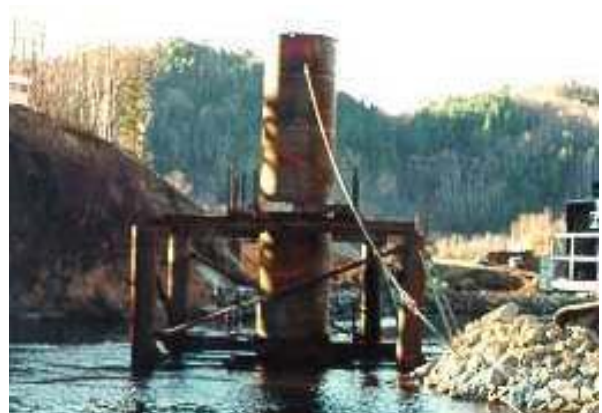
8. Cadre pour la mise en place d'un pieu caisson
