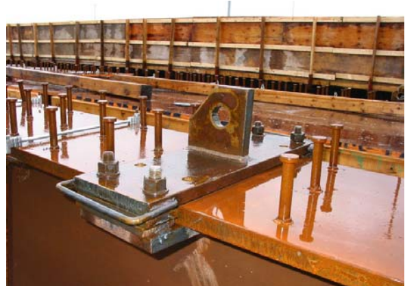
2. Ouvrage temporaire servant à la manipulation des poutres
