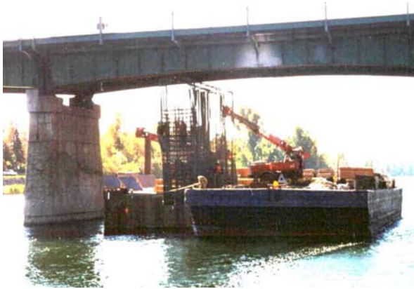
7. Accès à partir d'une barge
