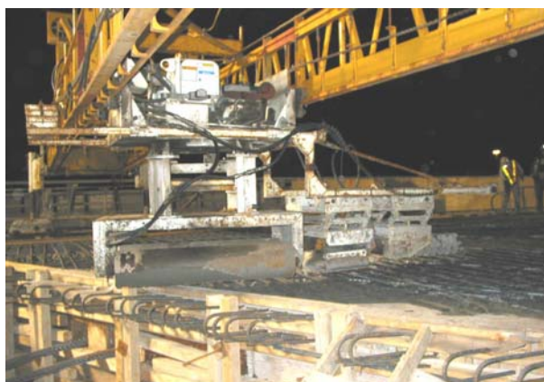
29. Détail du module mobile du finisseur automateur
