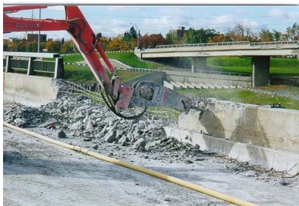
5. Démolition de glissière avec marteau hydraulique 350 J
