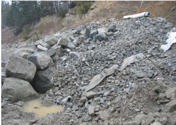
21. Revêtement en pierres lors de la construction
