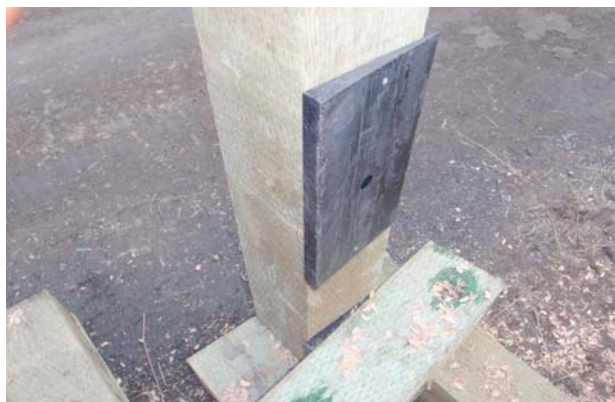
4. Espaceur pour pont avec biais
