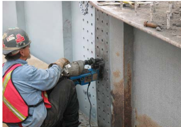
6. Perçage à la mèche avec gabarit (perceuse magnétique)
