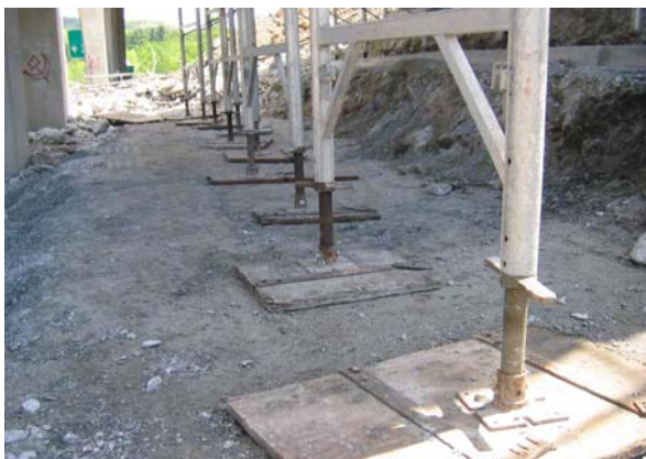
11. Détail de la base des étais (poteaux)
