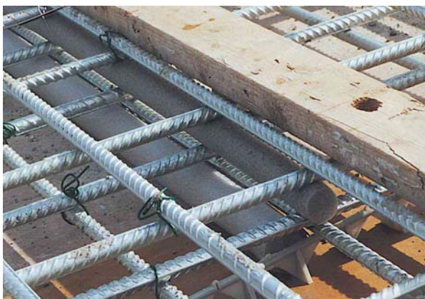
35. Boudins pour joint de construction d'urgence
