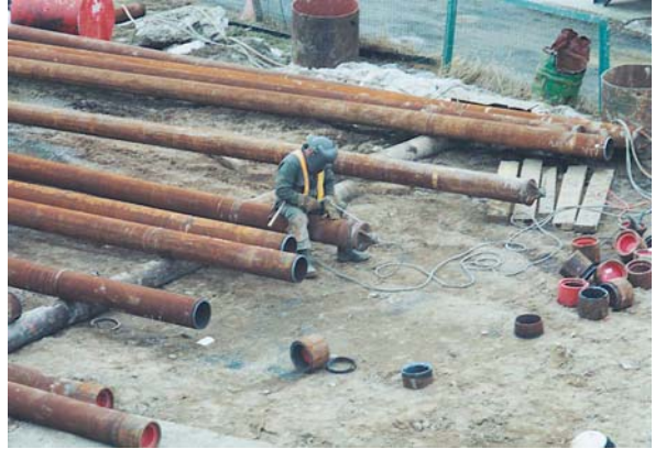
2. Pieux tubulaires en acier
