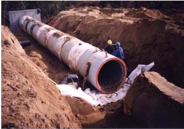
1. Installation d'un tuyau en béton armé (TBA)
