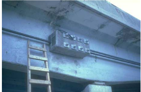
8. Précontrainte extérieure (renforcement)
