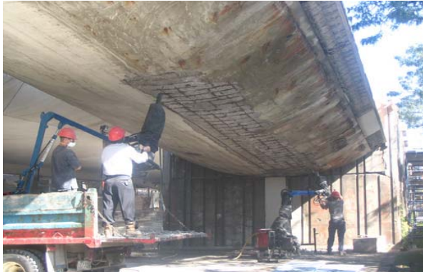
7. Utilisation d'un équipement de support pour marteau pneumatique manuel
