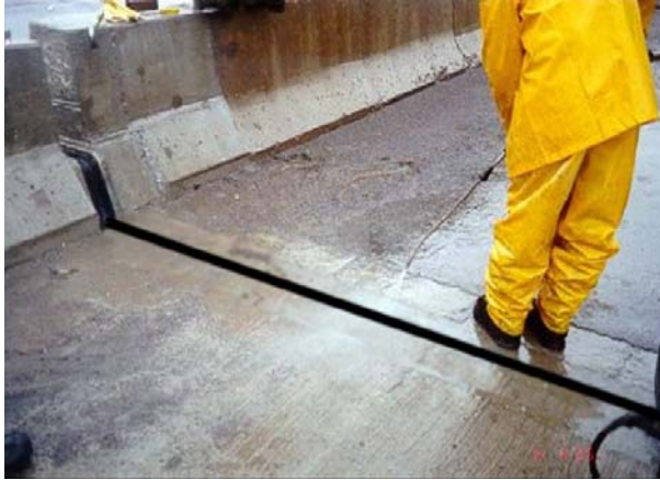
7. Essai d'étanchéité d'un joint de tablier
