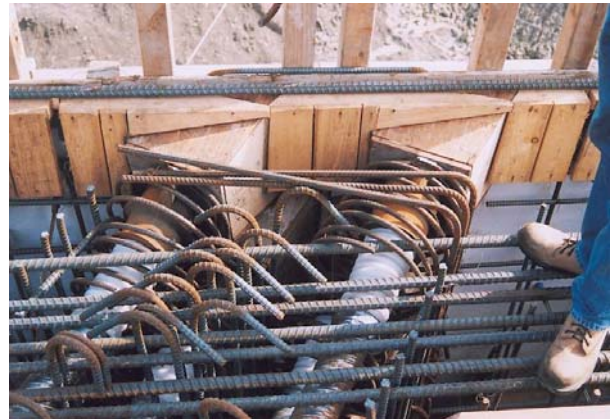
4. Armature de frettage
