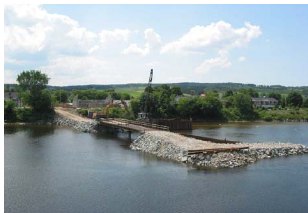
6. Chemin d'accès avec pont temporaire
