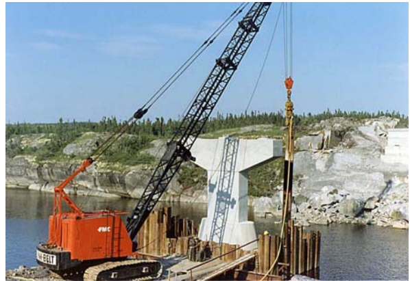
14. Enlèvement des palplanches métalliques
