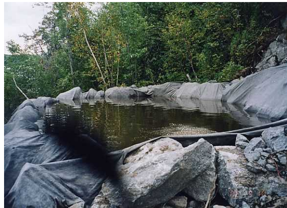
16. Bassin de sédimentation
