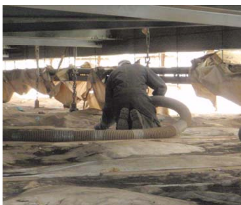
3. Nettoyage des abrasifs utilisés avec aspirateur
