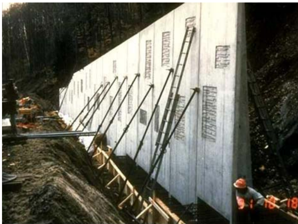
5. Mur en porte-à-faux en béton armé préfabriqué
