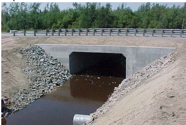
5. Ponceau rectangulaire en béton armé
