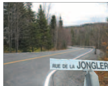
Pavage rue de la Jonglerie
