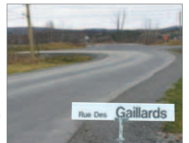
Pavage rue des Gaillard
