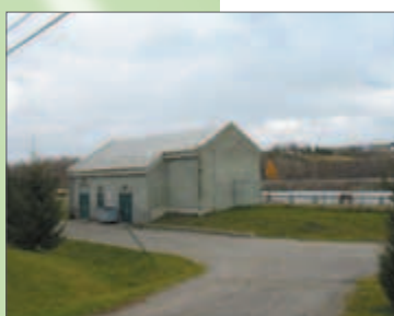
Vidanges des boues – usine d'épuration
