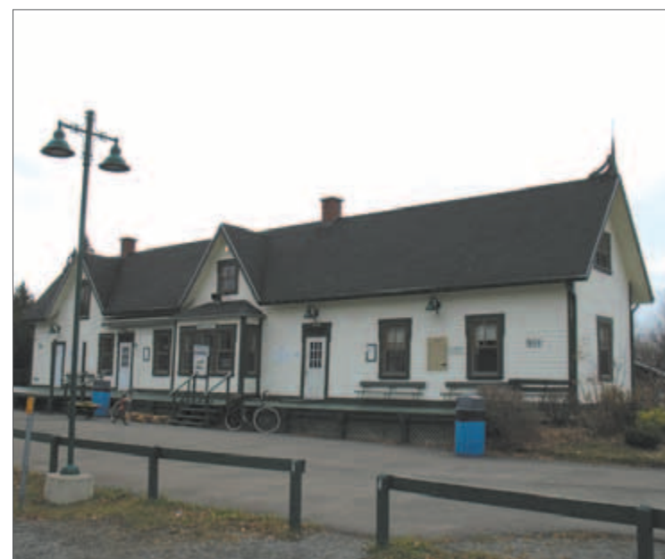
Peinture extérieure de la Gare de Prévost
