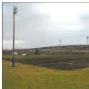
Éclairage du terrain de soccer des Clos
