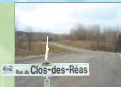
Construction rue du Clos-des Réas
