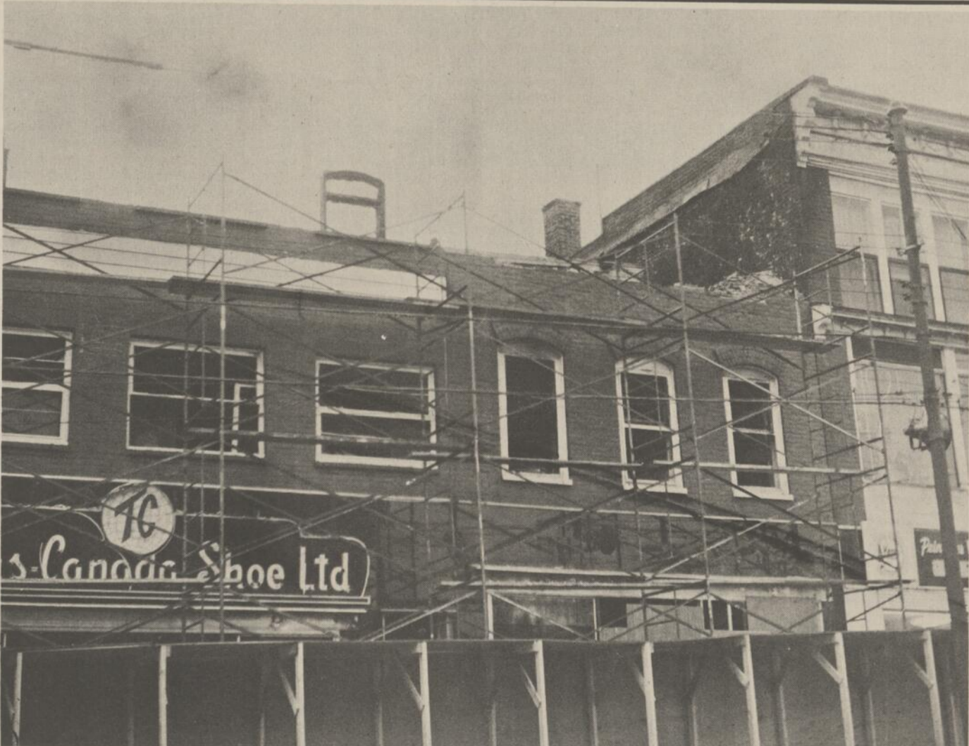
LE PIC du démolisseur a commencé à s'attaquer à l'immeuble situé au 165 rue Principale, qui avait été la proie des flammes, il y a quelques semaines, alors que plus de 40 pompiers avaient combattu l'élément destructeur pendant six heures, réussissant ainsi à éviter tout danger de conflagration. La bâtisse, propriété de Mlle Clara Dupré, 91 ans, de Granby, sera complètement démolie d'ici huit jours. Selon l'administrateur des biens de Mlle Dupré, M. L.P. Bibeau, aucun projet de reconstruction n'a encore été considéré. D'autre part, le magasin Trans-Canada Shoe, qui logeait dans cet immeuble, s'installera du côté opposé de la rue Principale dans la bâtisse du magasin Reitmans, au coin de la rue Johnson. Des travaux se poursuivent présentement afin d'aménager une partie du magasin Reitmans qui deviendra le nouveau magasin Trans-Canada. Reitmans est ouvert pendant la durée des travaux qui n'entravent nullement les allées et venues de la clientèle. L'établissement Reitmans continuera d'ailleurs d'opérer après la fin des travaux puisque Trans-Canada Shoe ne louera qu'une partie de l'immeuble. (Photo Matton)
