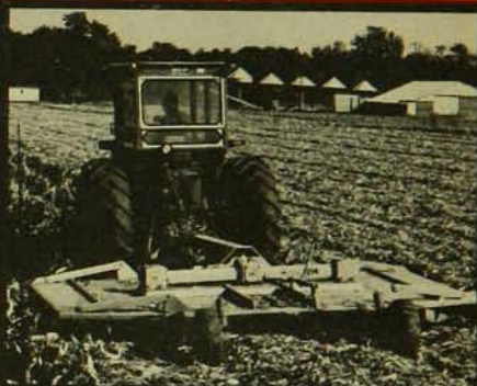
Le modèle 214 coupe 14' à la fois et fauche ou déchiquette jusqu'à 100 acres par jour.
