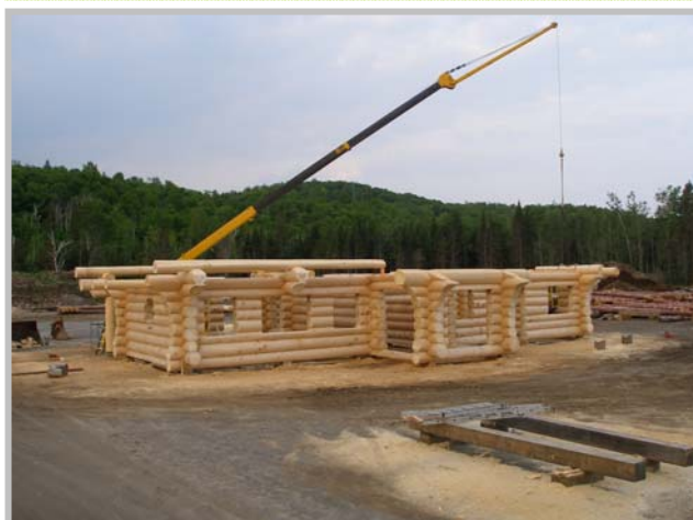
Maison scandinave en construction chez Structures en Bois Rond Harkins à Saint-Faustin-Lac-Carré
