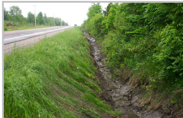
Fossés – méthode du tiers inférieur (Photo : Ministère du Transport du Québec)
