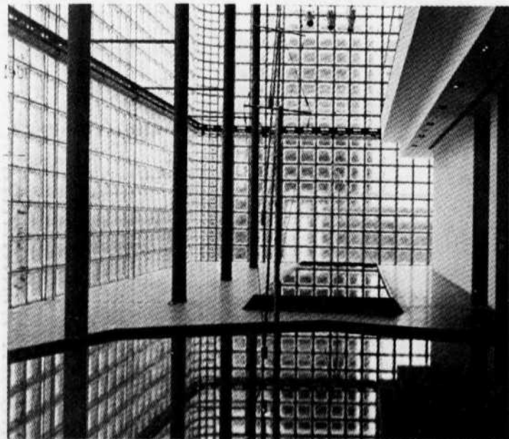
RENZO PIANO BUILDING WORKSHOP L'immeuble du magasin Hermès à Tokyo est fait de 13 000 pavés de verre transparent.
