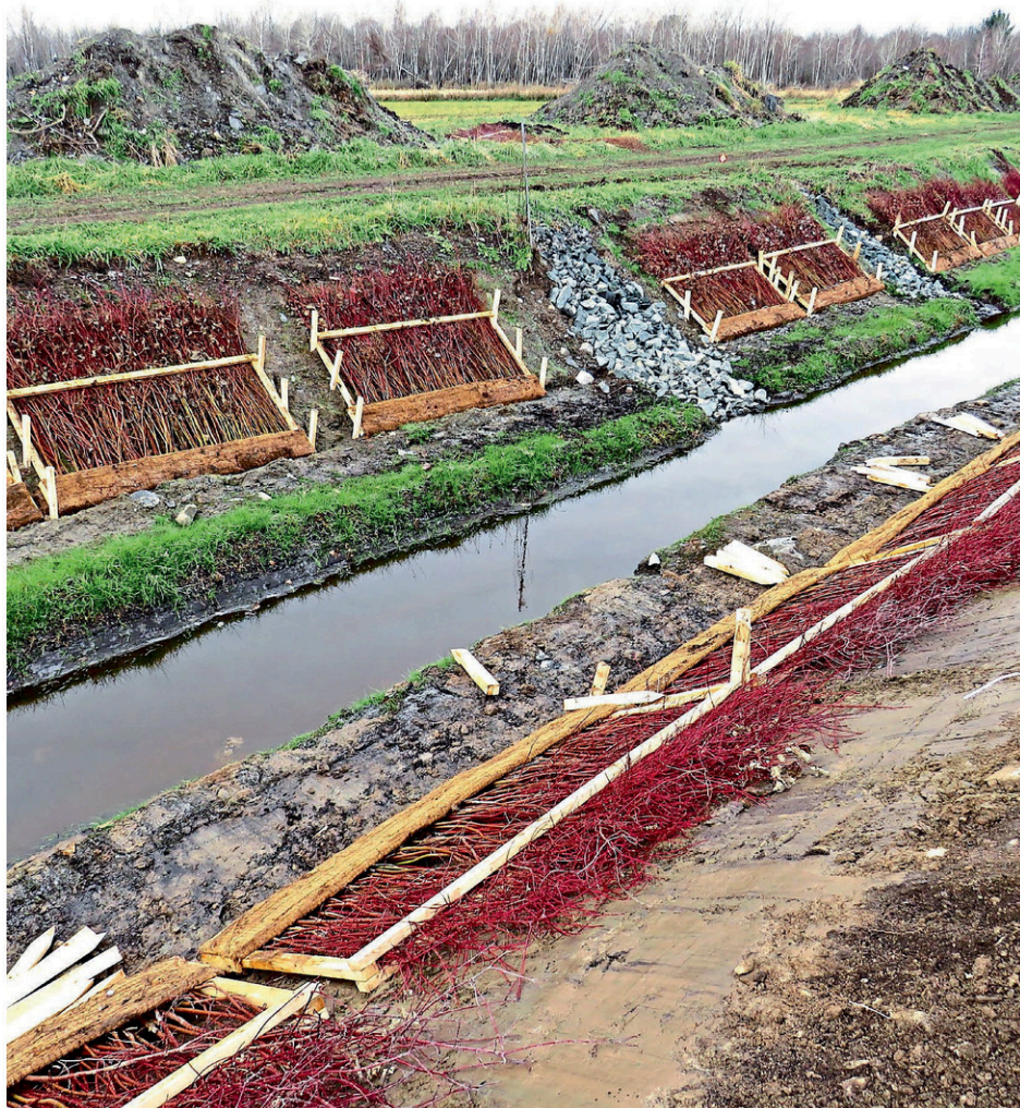
La mise en place de panneaux de cornouillers le long de la rive du chenal à deux niveaux aidera à stabiliser les berges du cours d'eau. (Photo: gracieuse)
