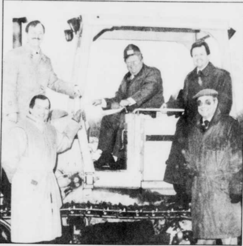
La mise en chantier du centre de distribution de la compagnie Paul Héroux ltée a été officialisée, hier, à Grand-Mère. Ci-dessus, on retrouve M. André Pleau, chef de secteur de la Brasserie Molson-O'Keefe pour la Mauricie, M. Michel Héroux, représentant des ventes, M. Paul Héroux, de la compagnie Paul Héroux ltée et président des Distributions Molson-O'Keefe Mauricie-Drummond, M. Mario Hallé, vice-président à la distribution de la Brasserie Molson-O'Keefe, et le maire de la ville de Grand-Mère, M. Jacques Marchand.
