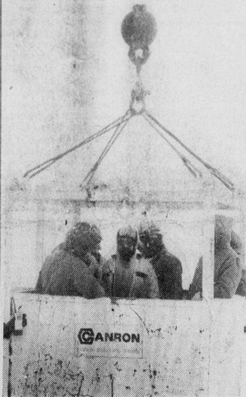
Les travailleurs prennent place dans une nacelle et une grue les soulève jusqu'au sommet du pont. (Photo Le Soleil, Jacques Smith)
