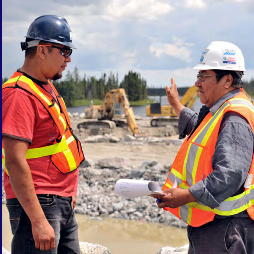
Daniel Georgekish et Danny Kitchen, travailleurs au chantier de l'Eastmain-1-A, secteur Rupert.
