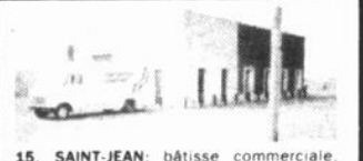
15. SAINT-JEAN: bâtisse commerciale, 4 960 pi carrés, construction blocs de ciment, brique et aluminium, très bien située, grand stationnement. Gad Dumouchel
