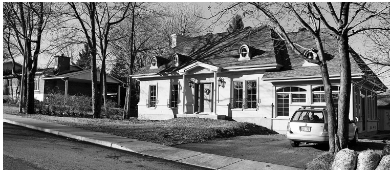
Il a fallu près d'un an pour transformer en demeure de prestige le modeste bungalow que le maire Gascon avait acquis en 1988. — PHOTO LA PRESSE, ALAIN ROBERGE
