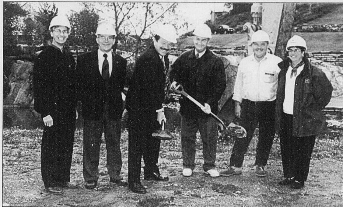
ASSAINISSEMENT — Le député-ministre de Lac-Saint-Jean, Jacques Brassard, et le maire Léonard Côté, d'Hébertville, se sont prêtés volontiers, hier matin, au jeu de la première pelletée de terre en bordure de la rivière des Aulnaies dont on a complété l'aménagement des abords depuis la disparition du moulin à scie. Ils étaient accompagnés de Gaétan Bouchard de Cégertec, de Robert Tremblay, de Roch Savard d'Excavation JR Savard Ltée, et de Josée Garon de Génivel.
