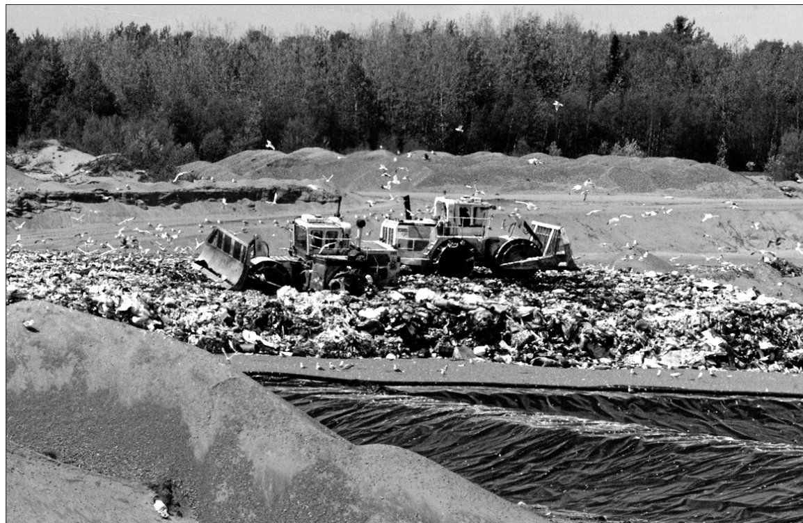
La Régie veut modifier la géométrie des cellules d'enfouissement pour enfouir plus de déchets dans chacune d'elles.
