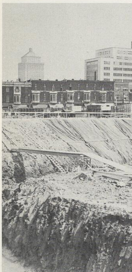
L'excavation en talus de la colonnade de la façade de la salle.
