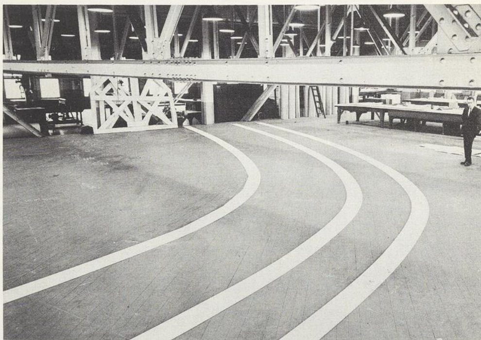
Vue des gabarits destinés à préparer les coffrages de la façade circulaire de la salle de concert que l’ingénieur Pierre Bernard a tenu à tracer lui-même, étant donné l’ampleur et la complexité des courbes elliptiques.
