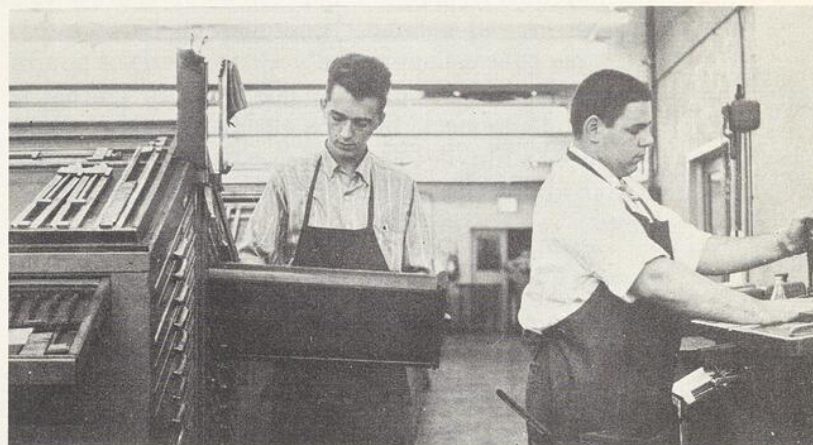
Une fois le titre préparé, le composteur est inséré dans une machine Ludlow (à droite) où le plomb est coulé en une seconde.
