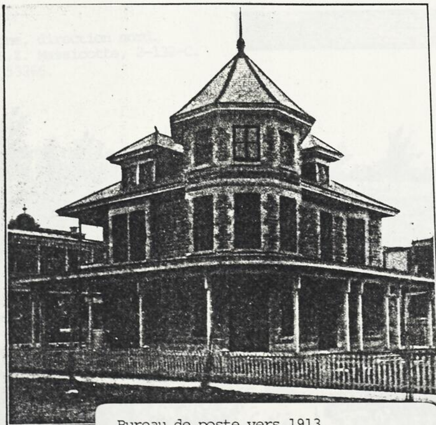
Bureau de poste vers 1913. A.M.M. - 3035.46-30/A. S.U.V.M. - 54614.
