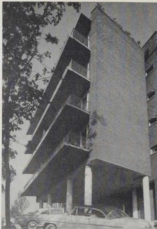
La maison d'appartements est assise sur un rocher et on y accède par une forte pente. L'entrée, sous le bloc qui apparaît ici, est vue en détail à droite (page suivante). Muraille de Louis Archambault intégrée au mur extérieur de l'entrée.
