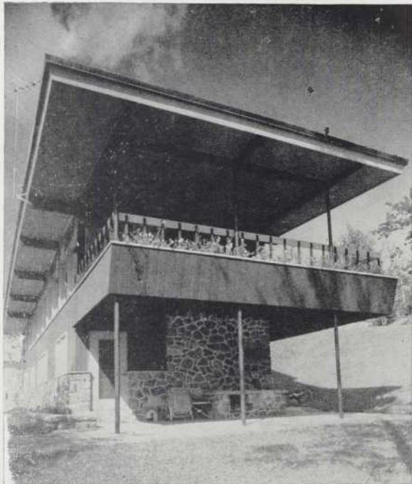
Vue de la terrasse élevée, à l'ouest. Elle sert également de toiture à une autre terrasse au rez-de-chaussée, avec foyer extérieur.
