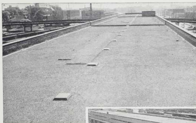
Toiture composée Carey de la Gare aux Marchandises.
