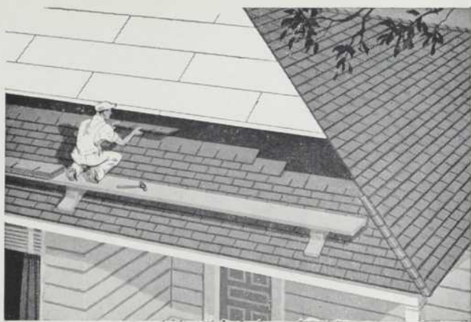
Le bardeau Homasote pour toitures plates, en faite ou à pente unique est offert en lisières de 21/32", 15/16", 1 3/8" et 1 7/8".
