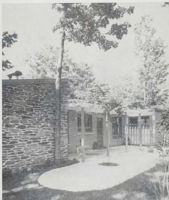
Vue de la terrasse et de l'arrière de la maison, au sud. On notera l'intimité de cette façade qui donne sur un jardin privée, à côté de l'austérité de l'élévation principale qui regarde la rue.
