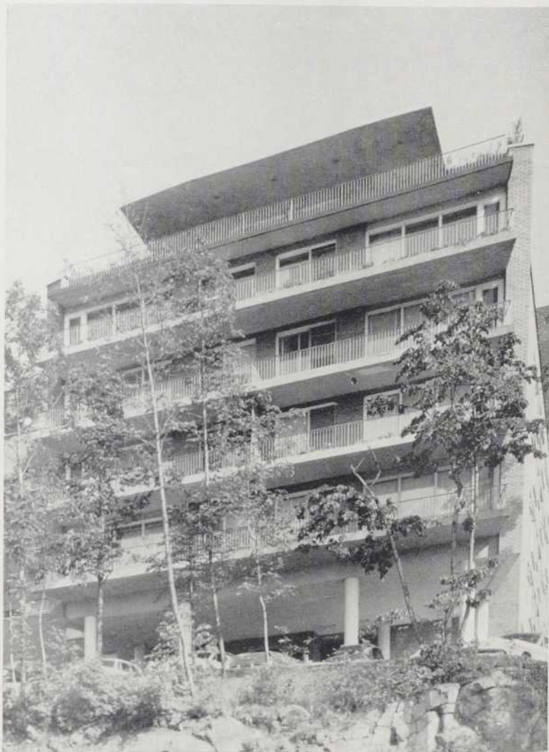
Les balcons en porte-à-faux servent à deux logements par étage dans le bloc qui projète en façade. Le porte-à-faux supérieur abrite la terrasse du logement du propriétaire.
