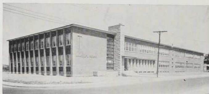
Ecole Immacolata à Ville St-Laurent Architectes : DUFRESNE & BOULVA
