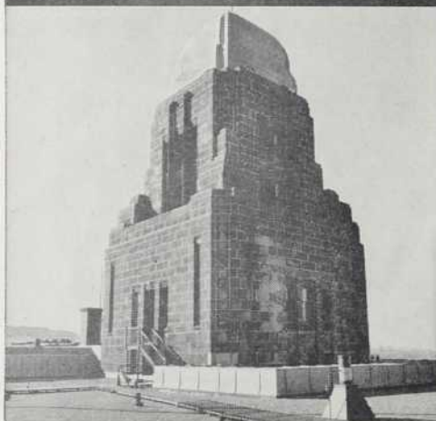
L'édifice du gouvernement fédéral, à Halifax, N.-E., dont la toiture est en Monel. Entrepreneurs: Northern Roofing and Metal Workers Ltd., St-Jean, N.-B.
