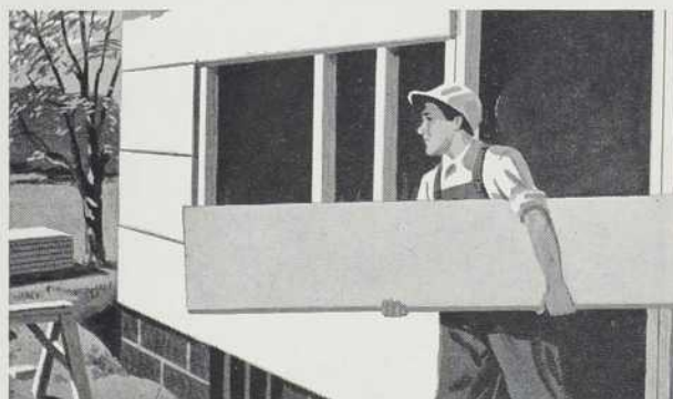
Le revêtement Homasote de 21/32" — sans asphalte — est offert en panneaux de 2' x 8' à rainure en V et en plus grands formats, allant jusqu'à 8' x 14'.
