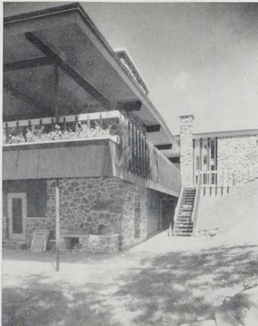
Deux détails de façade. Pierre des champs avec joint généreux, bois brun avec apport de jaune pâle.
