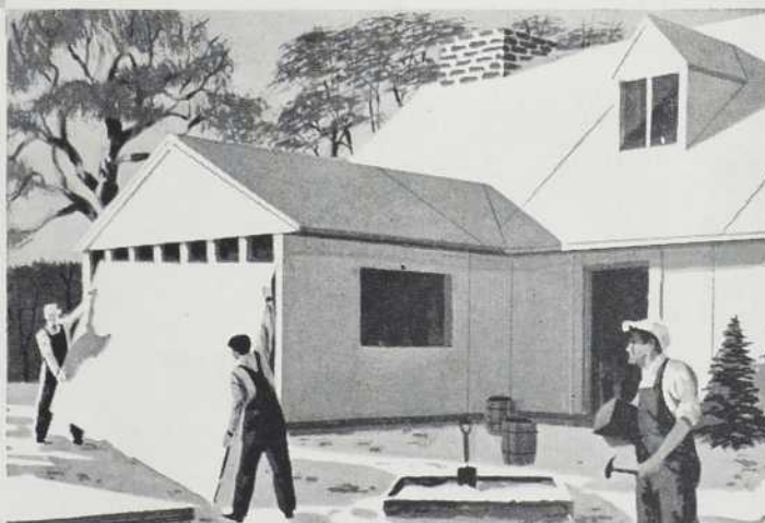
Les panneaux Homasote de 8' x 14' — épaisseurs de 15/32" ou 21/32" — sont employés comme revêtement pour murs ou toitures.
