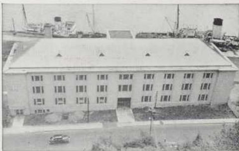
Toit en Monel sur l'immeuble de la Marine, à Québec, P.Q. Entrepreneurs pour la toiture: Adelaar Laberge Liée, Québec, P.Q.
