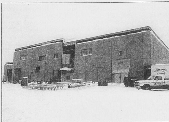
BÉTON - Il a fallu 5300 mètres cubes de béton pour ériger toute l'infrastructure de l'usine et le bâtiment.
