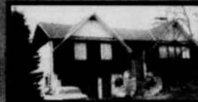
De grand luxe, près de l'hôpital, 616 pces, pl. chêne, s.s. fini pour bureau professionnel. Elle est belle.
