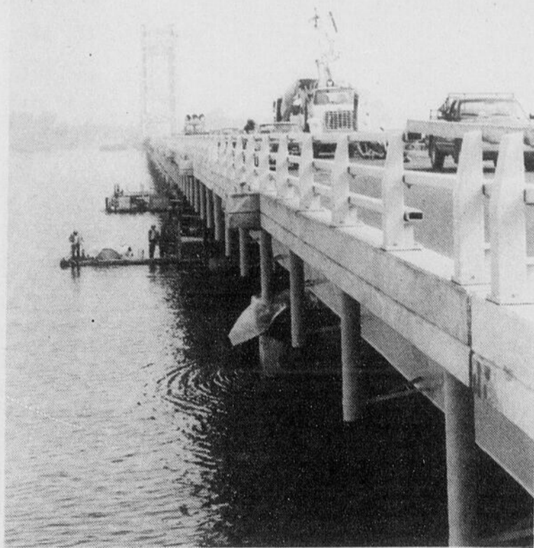
Déjà 13 nouvelles travées ont été installées sur le pont Larocque à Valleyfield. Notons que le travail est exécuté pendant la nuit mais que la préparation s'effectue le jour. (Photo Le Soleil - Jacques Smith).
