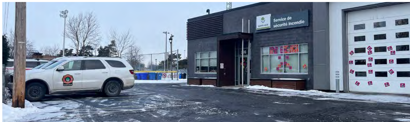
La caserne de pompiers à Sainte-Julie est située sur la rue Bernadette. (Photo: Marie-Pier Ouellet)
