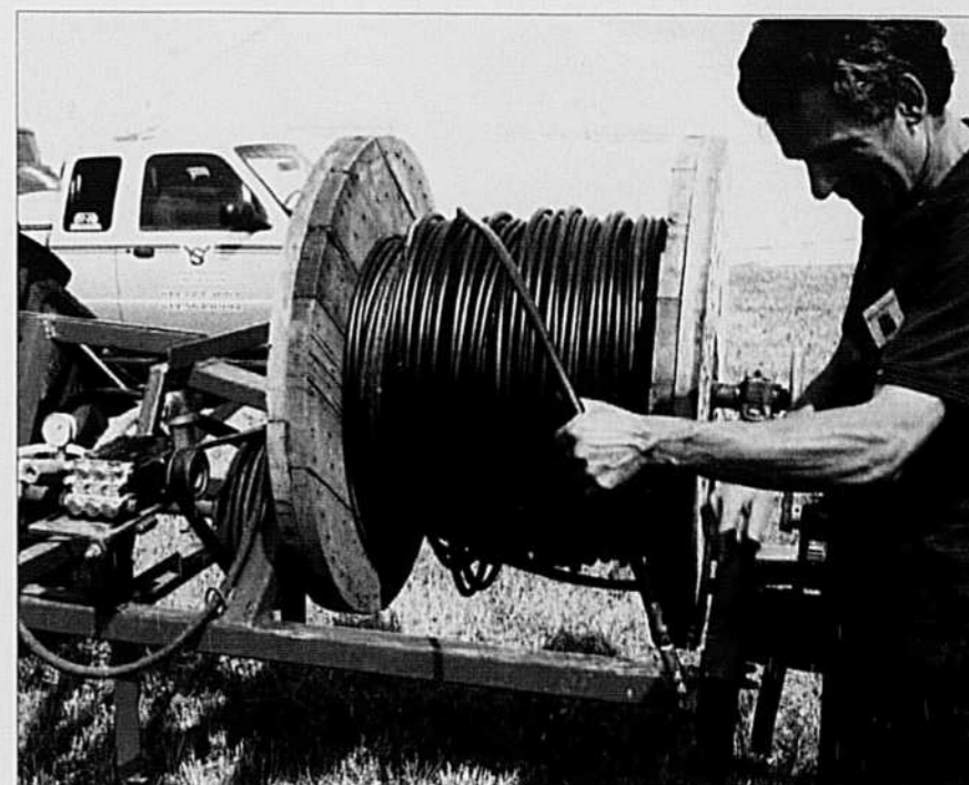
Un tuyau de ½ pouce de diamètre et de 1000 pieds de long est équipé d'une buse inversée.
