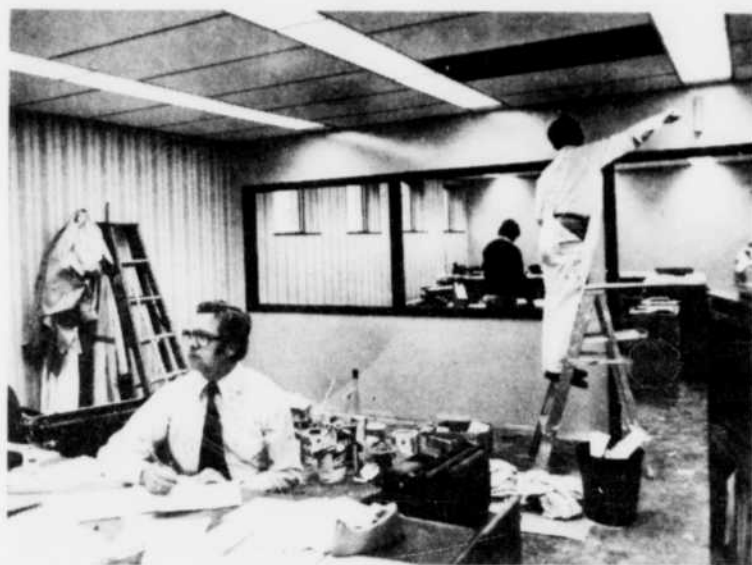
Même si les travaux ne sont pas tout à fait terminés au bureau de l'agence-expédition, on peut déjà voir la différence...
