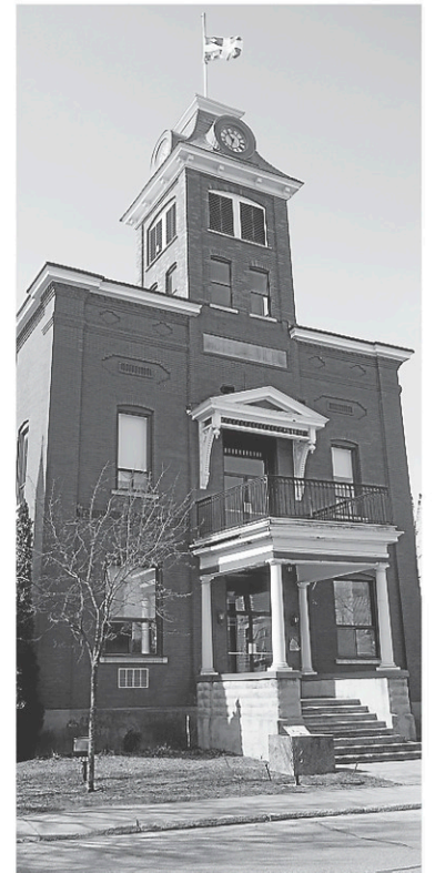
Les 3 e et 4 e étages à l'arrière de l'hôtel de ville de Farnham feront l'objet d'importants travaux de mise aux normes de protection incendie en 2017. — PHOTO ALAIN DION, ARCHIVES LA VOIX DE L'EST
