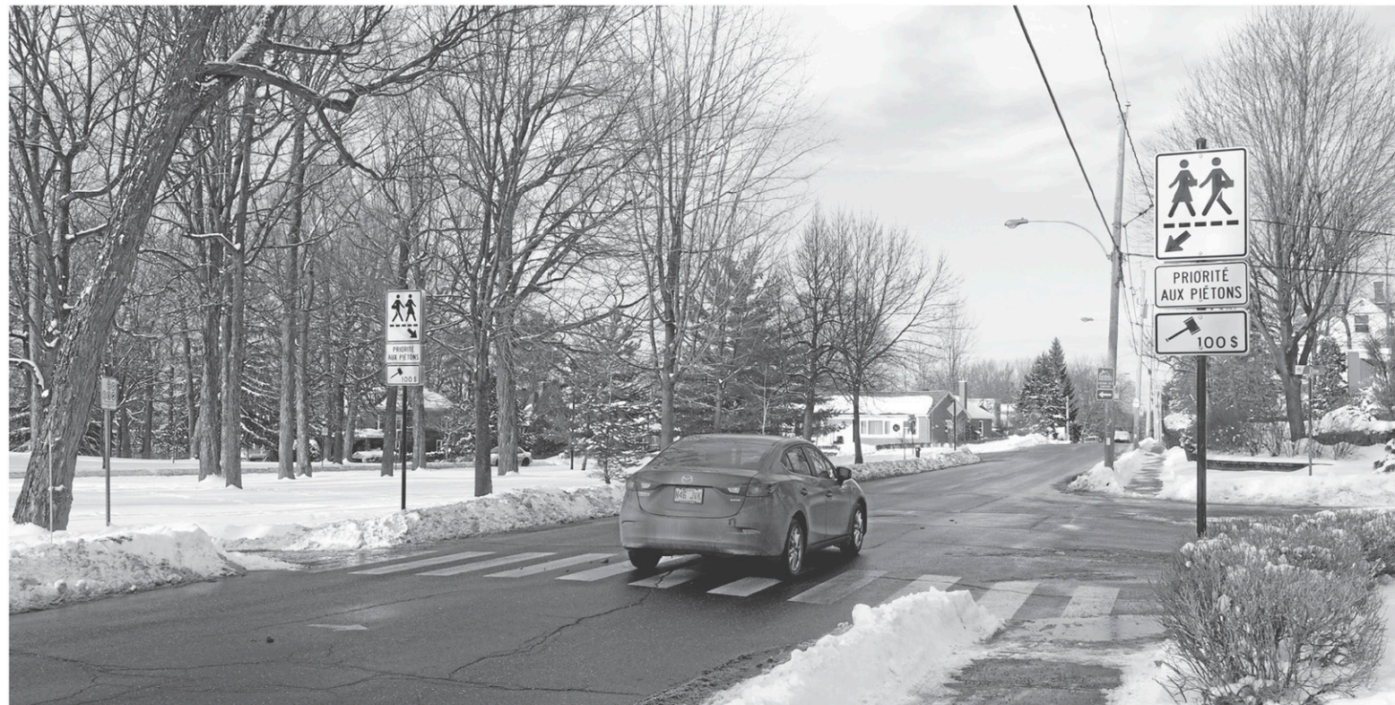
Entre autres mesures envisagées pour ralentir et sécuriser la circulation rue Elgin à Granby, une traverse piétonnière surélevée pourrait être aménagée au sud de l'intersection des rues Elgin et Elm. — PHOTO ALAIN DION
