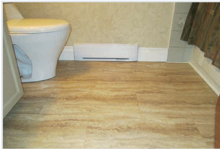
Le plancher de vinyle flottant hydrofuge ne craint pas les endroits humides, comme la salle de bain ou le sous-sol.
