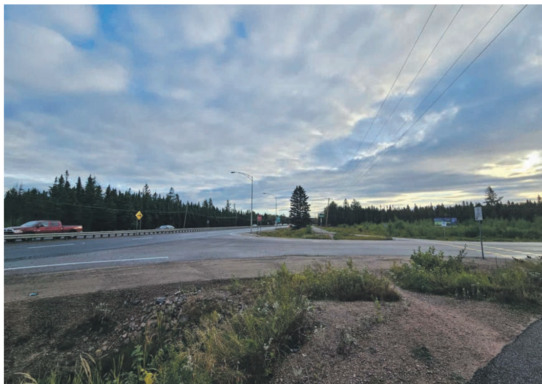
Construction d'une intersection au coin de la rue des Hémérocalles et du boulevard Pierre-Ouellet. Photo Karianne NEPTON-PHILIPPE
