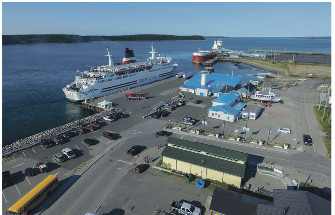
Une partie du Port de Havre-Saint-Pierre. Courtoisie Port du Havre-Saint-Pierre
