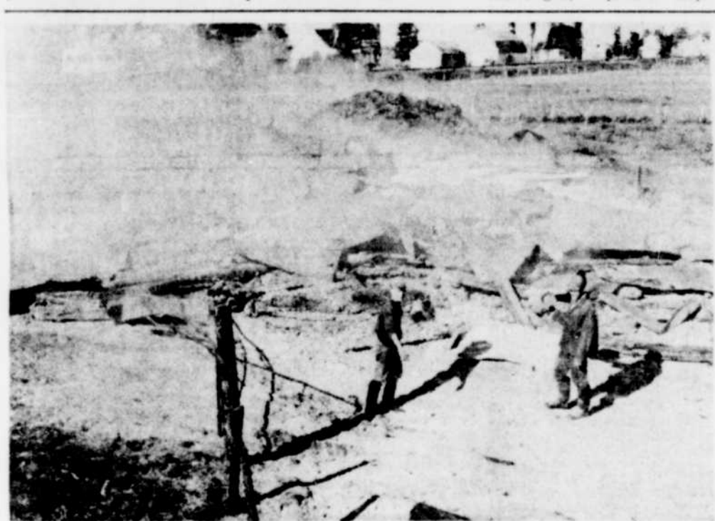
LES FLAMMES ACTIVEES par un vent violent, ont mis moins d'une heure pour raser au sol les bâtiments de ferme de M. Georges Descoteaux, à la Pointe-du-Lac, hier matin. Cette photo fut prise alors que tout n'était que ruines.
