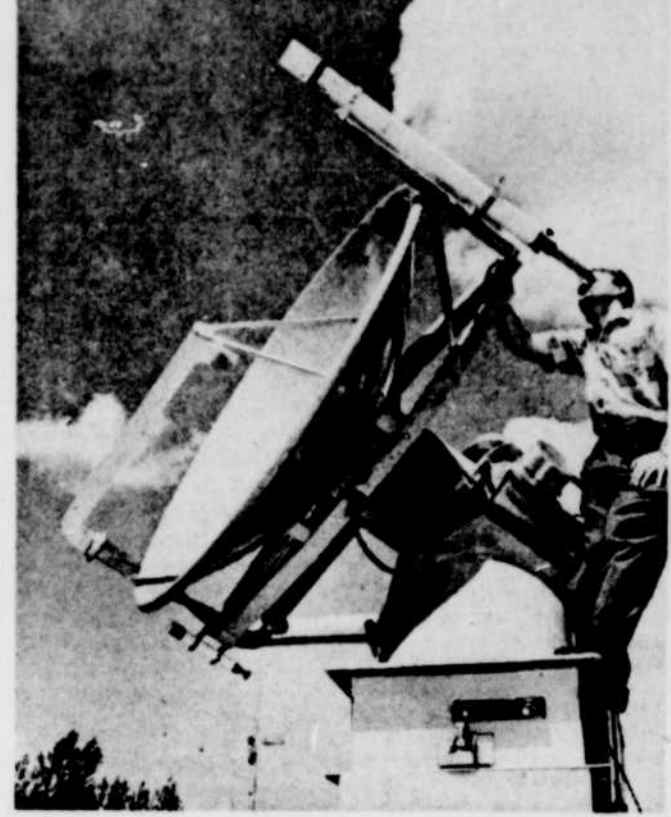
UN REFLECTEUR PARABOLIQUE de 6 pieds de diamètre servira aux ingénieurs du Conseil national des Recherches d'Ottawa, lors de l'éclipse solaire du 20 juillet. Il sera relié à un récepteur de radio afin de mesurer les ondes émises par le halo du soleil à cette occasion. Sur cette photo, nous voyons M. Paul H. Gagnon, du Conseil national des Recherches, utilisant le télescope qui permettra de scruter les divers phénomènes qui se produiront le 20 juillet.
