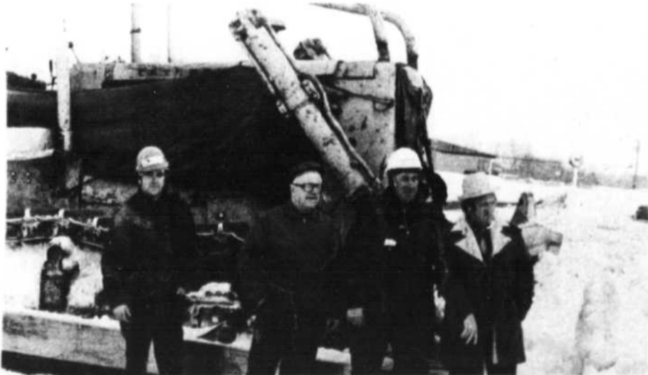
Cette photo fut prise alors que l'on procédait aux premiers travaux de nivelage sur le terrain où sera construit le Centre Professionnel de Mascouche. On reconnaît ici M. Charles-Émile Rivest (à droite) de la firme L'Archevesque & Rivest, entrepreneurs généraux, discutant avec son contremaître de chantier, Louis-Gilles Marsolais et M. Yves Malouin, de la firme C.E. Malouin & Fils à qui ont été confiés les travaux de plomberie. A l'extrême gauche, on reconnaît M. Louis-Gilles Marsolais, un des employés de L'Archevesque & Rivest.
