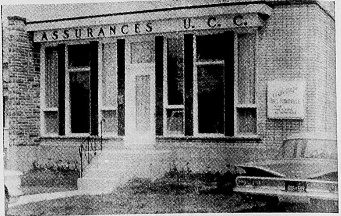
C'est dans le sous-sol de l'Agence des assurances de l'UCC, à St-Eustache, que l'on retrouve maintenant le secrétariat de la Fédération de l'UCC de Montréal-St-Jérôme. Enfin, un local à soi, en plein cœur du territoire.
