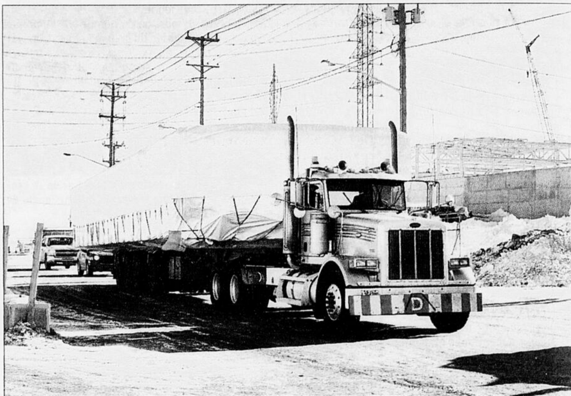
Le premier caisson, livré par le fabricant baieriverain Charl-Pol sur un camion-remorque, mesure 18 mètres par quatre mètres de largeur, l'équivalent de la superficie du carré d'un petit bungalow, et pèse 45 tonnes. Il est destiné au Centre technologique AP60.
