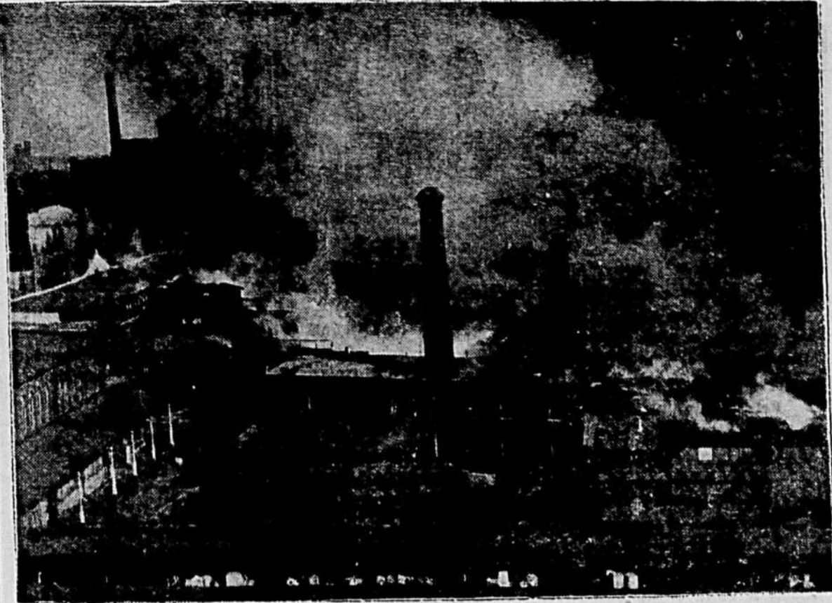
Instantané donnant un aperçu de l'incendie qui a ravagé la semaine dernière la bâtisse abritant les bureaux de la vieille gare Bonaventure, à Montréal. Les cours de triage du Canadien National ont aussi été sérieusement atteints. Une centaine de wagons de marchandises et leur contenu ont été détruits. On évalue les dommages à plus d'un million de dollars. Certaines autorités du chemin de fer national parlent même de quelques millions.
