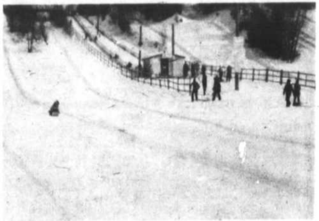
Vue d'ensemble du merveilleux site de Val Cartier.
