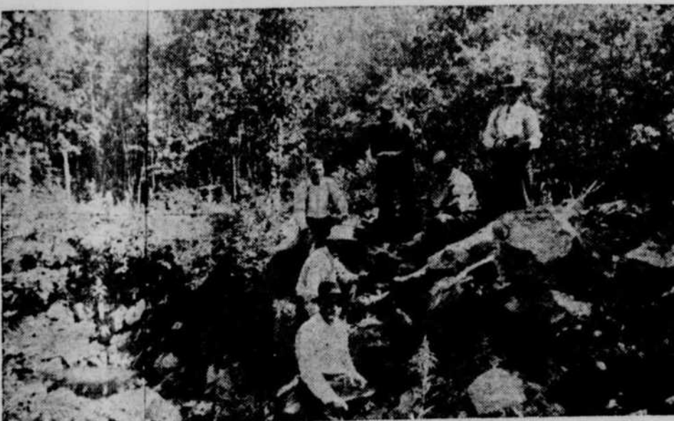
Vue d'une riche tranchée où se font encore des travaux d'exploitation.
