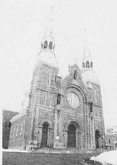
L'entretien de la basilique Sainte-Anne coûte cher (photo: Martin Grenier/PPM)
