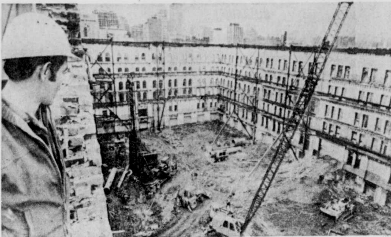
On conserve les murs
