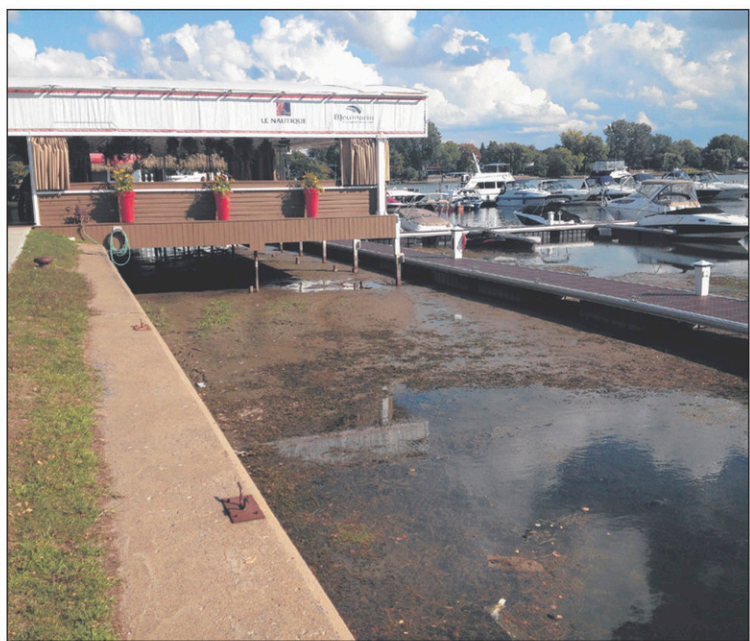
Il n'y a plus d'eau sous la terrasse du restaurant le Bleu Marin.
