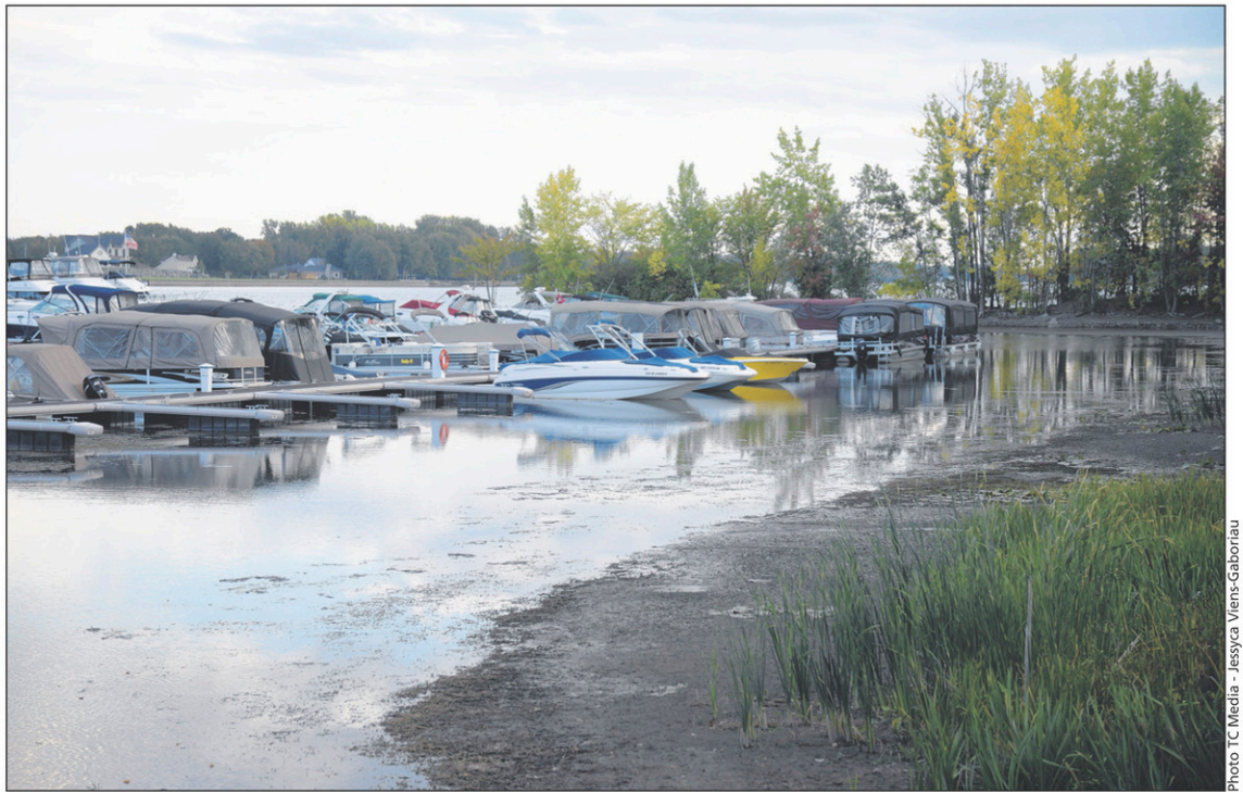
À la marina Le Nautique, des quais reposent sur la vase.
