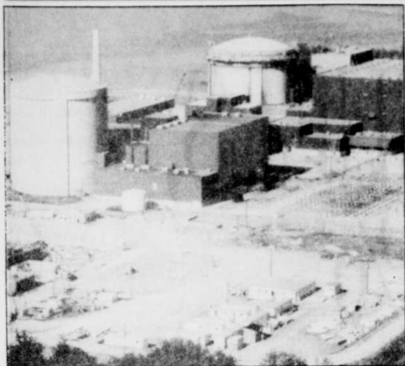
La centrale nucléaire Gentilly 2, dans le parc industriel de Bécancour.
