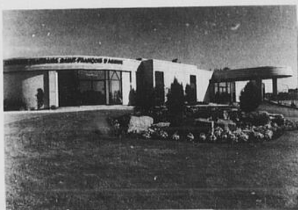
Complesso Saint-François d'Assise 6700, rue Beaubien Est
