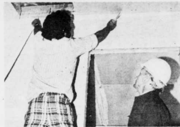
Un inspecteur de la Société centrale regarde un ouvrier ponter et obturer les joints formés par deux panneaux de mur sec; une fois pontés, obturés et poncés, les joints sont presque invisibles après l'application de la peinture.
