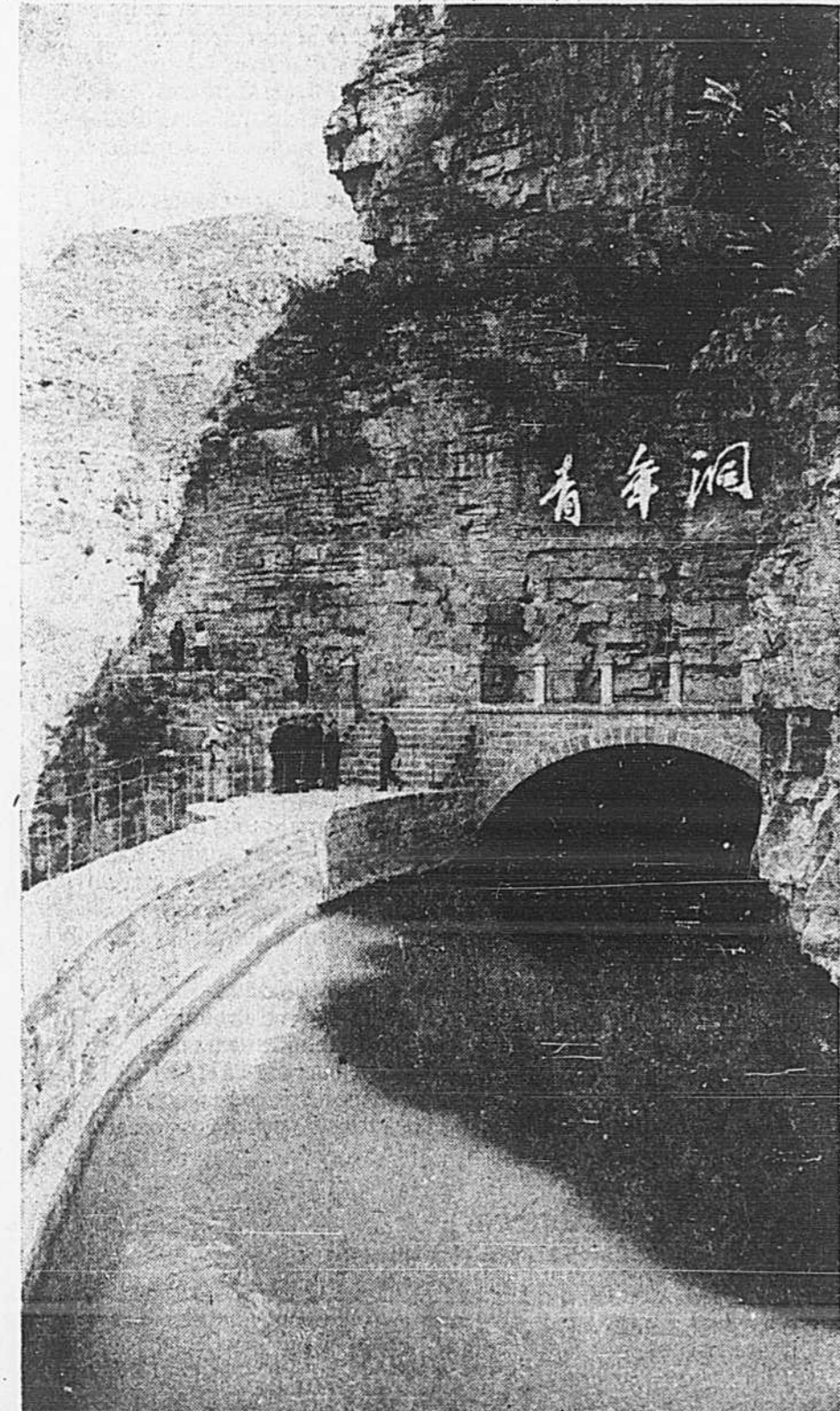
Le tunnel de la jeunesse. Il fallu percer un corridor à travers le roc pour permettre au canal de continuer sa course. Le canal passe à travers un total de 134 tunnels.
