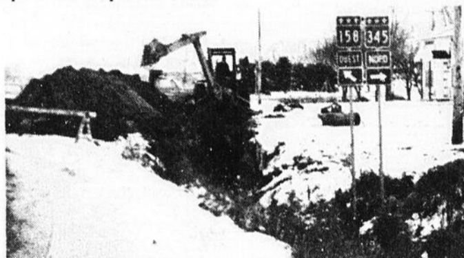
Des travaux sont en cours dans la paroisse de Berthier, plus précisément au rang Bayonne Sud. Ils ont débuté la semaine dernière. Ils visent à améliorer une canalisation d'eau à ciel ouvert qui causait des problèmes à certains résidents du coin depuis quelques années. Berthier-paroisse recevra pour ces travaux une subvention de $5,000, au maximum.
