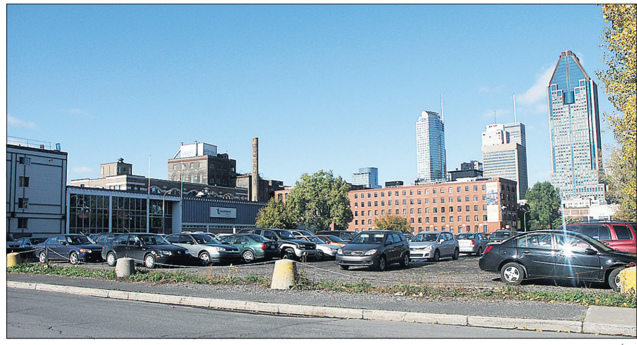
Le quartier Griffintown, situé à proximité du centre-ville, est en mutation. Un atelier de design urbain est organisé la semaine prochaine pour tous ceux qui s'intéressent à la revitalisation du secteur.
